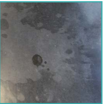
Um derramamento de refrigerante deixado em repouso por quase uma hora iluminou significativamente o concreto deste piso de concreto.
